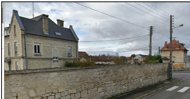
Mur de clôture
