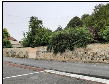
Mur de clôture
