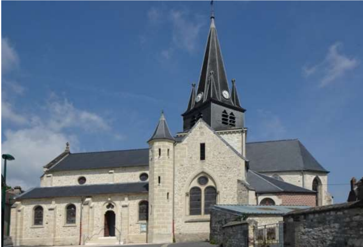
Figure 50 – Élément remarquable n°18 : Église de Ramecourt
