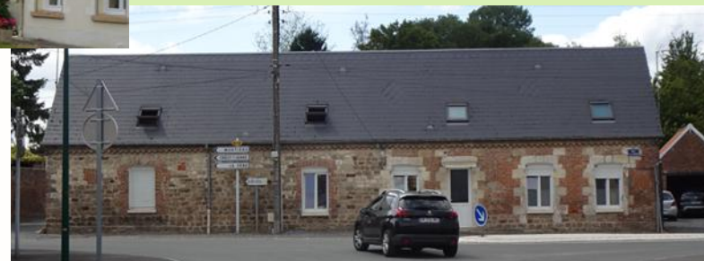
Dercy, Implantation en façade
