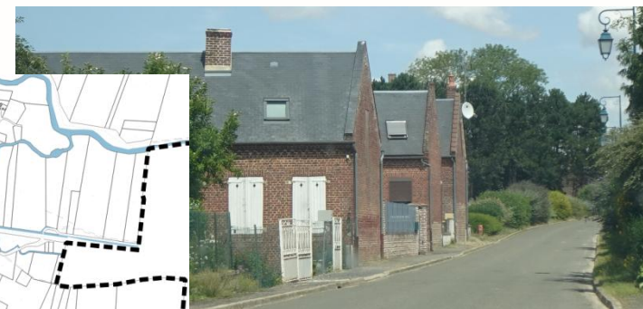
Bois-lès-Pargny, en pignon
