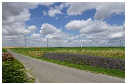
Parc éolien entre Cuirieux et Autremencourt
