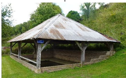
Lavoir à Tavaux-et-Pontséricourt
