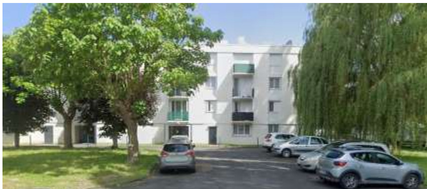
Petits collectifs rue de l'Avenir
