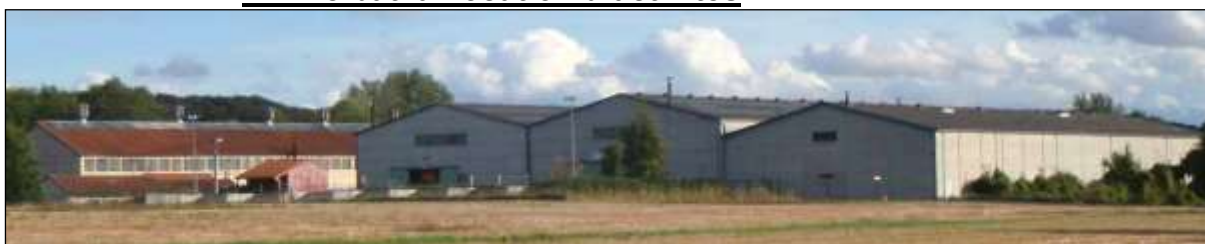
Bâtiments d'activités, rue de la Fontaine Saint-Minge
